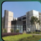
廣州研發生產物流中心 GuanZhou Factory
